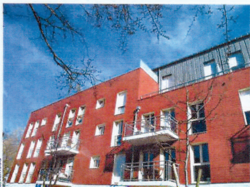
Bardage rapporté pour une isolation renforcée.
